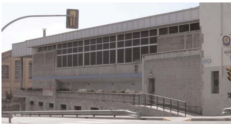
Un Poliesportiu en mal estat.
